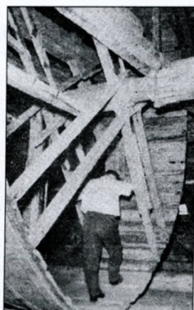
Ступенчатые вертикальное и горизонтальные колеса (топчаки) в мельнице (Agrikola_1556-315.jpg)
