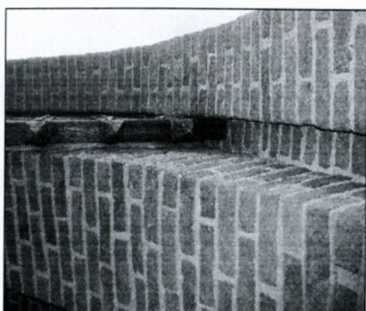
Ольштын (Польша), городская брама, вертикальный паз для движения герсы (реконструкция, Olsztyn, 18.05.2010)
