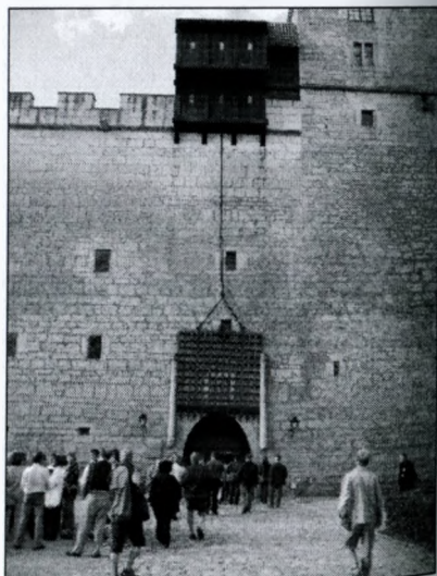
Замок Курессааре, остров Сааремаа (Эстония), замковая брама, общий вид брамы с герсой и воротами (Est, 26.08.2007)
