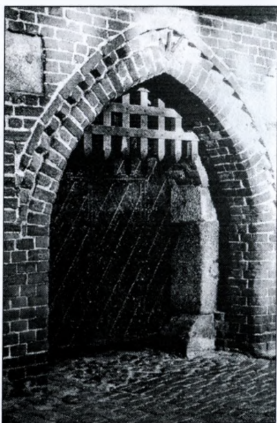
Кентшин (Польша), замковая брама, общий вид брамы с герсой и воротами (постер, музей Вармии и Мазур, Olsztyn, 18.05.2010)
