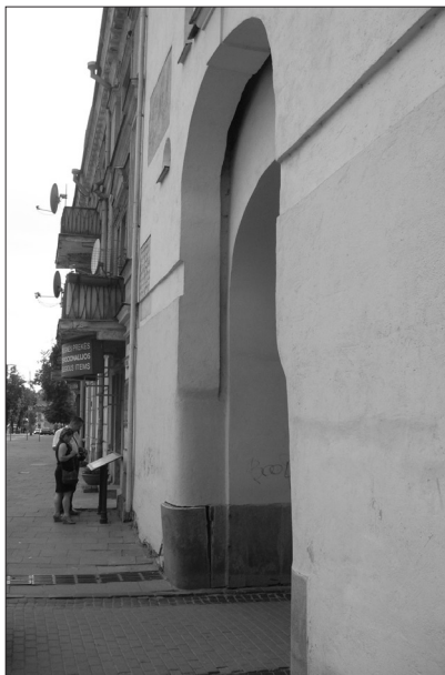
Виленькая Острья брама, вертикальный паз для движения герсы (Vilnius, 23.05.2010)
