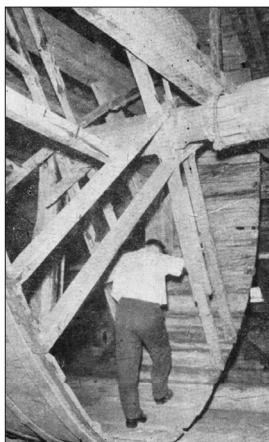
Ступенчатые вертикальное и горизонтальные колеса (топчак) в мельнице (Agrikola_1556-315.jpg)
