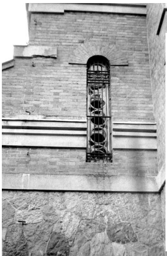
Архитектурная деталь (оформление оконного проема. 1974 г. Фото автора
